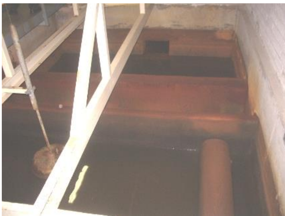
Рисунок 4.2.3.3 - Песчаный фильтр. Высота загрузки 0,8 м
