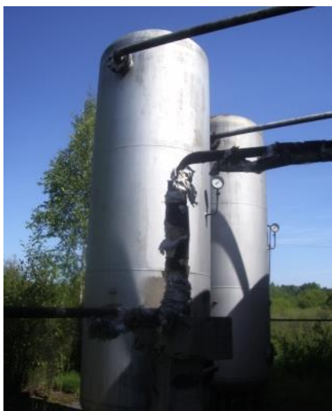
Рисунок 4.2.3.6 - Аэрационные баки ВОС пос. Вартемяги
